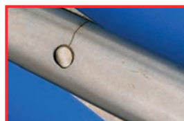
Haarriss im Gewindebereich einer Schere
